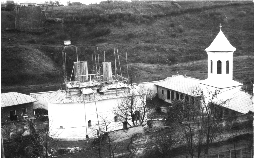
Fig. 1. Mănăstirea Clocoțiu, în reparație, 1976.
