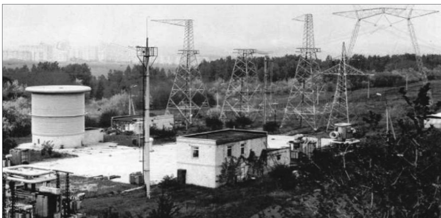
Vedere a stației IE ASM de încercări la tensiuni înalte cu generator de impulsuri cu tensiunea 2.5 MV
